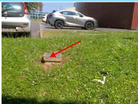
Matériaux : ZPSO-002 Prélèvement : Description : Conduit en fibres-ciment Localisation : Extérieur - Espace vert Résultat : Présence d'amiante
