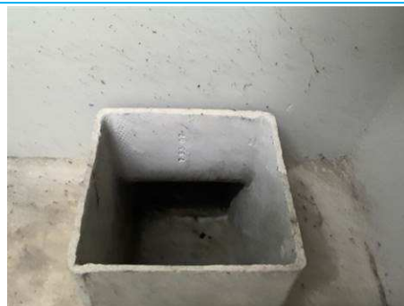
Matériaux : ZPSO-001 Prélèvement : Description : Conduit en fibres-ciment de ventilation Localisation : Sous-Sol - Local technique Ascenseur IA S04 Résultat : Présence d'amiante
